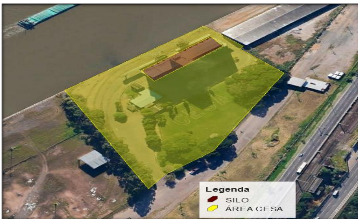
Figura 23 – Silos e área da CESA
