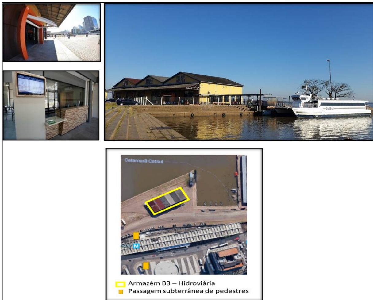
Figura 7 – Terminal de passageiros
