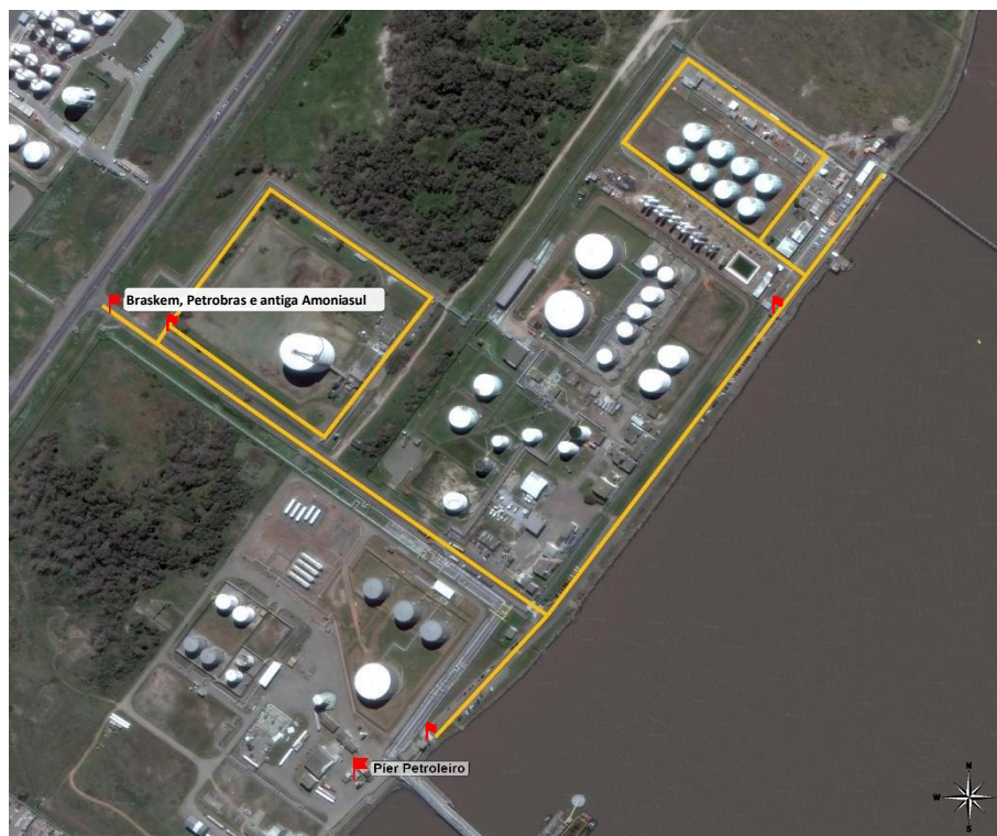
FIGURA 28 – Gates dos Terminais antiga Amoniasul (Brownfield 01), Braskem e Petrobras
