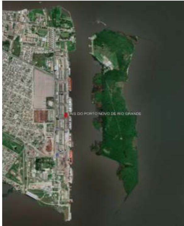
Figura 1: Vista geral das instalações do Porto de Rio Grande.
