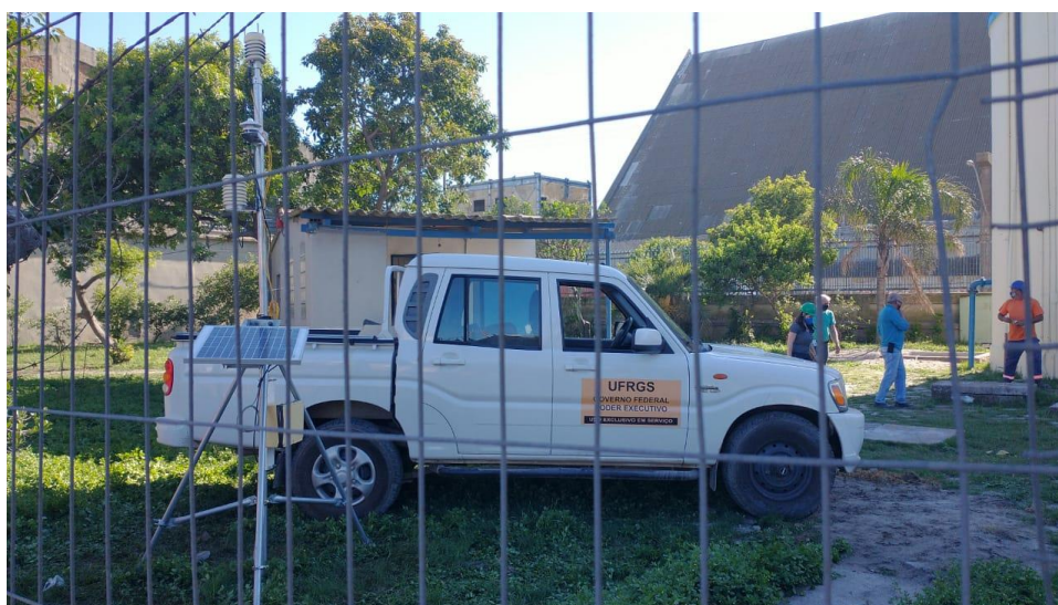
Figura 22 - Equipamento de monitoramento da qualidade do Ar instalado na área do Porto Público - Porto Novo. Fonte: Banco de dados DMA/Portos RS.
