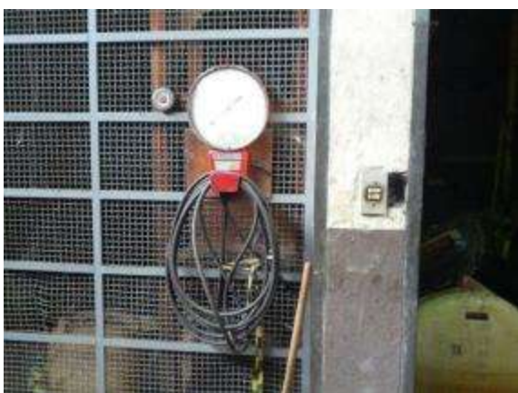
REGISTRO FOTOGRÁFICO DE LINHA PRESSURIZADA
