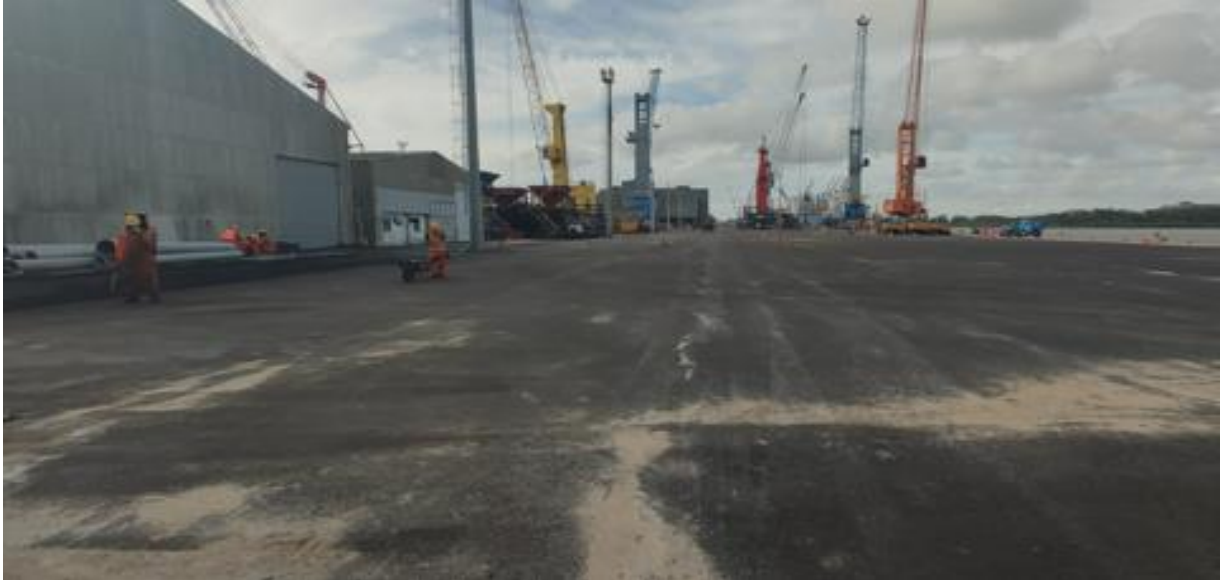
Foto 2: Asfaltamento das vias internas do Porto Novo.
