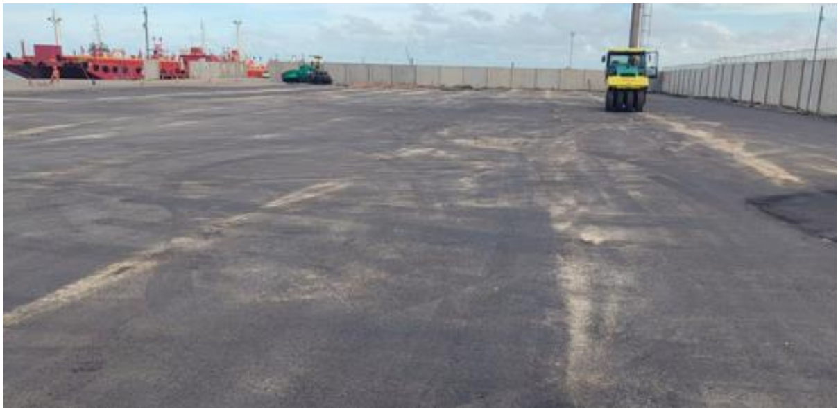
Foto 3: Asfaltamento das vias internas do Porto Novo.
