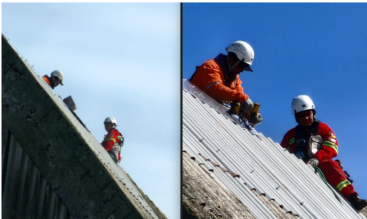
Foto 1: Manutenção realizada no telhado do armazém D3
