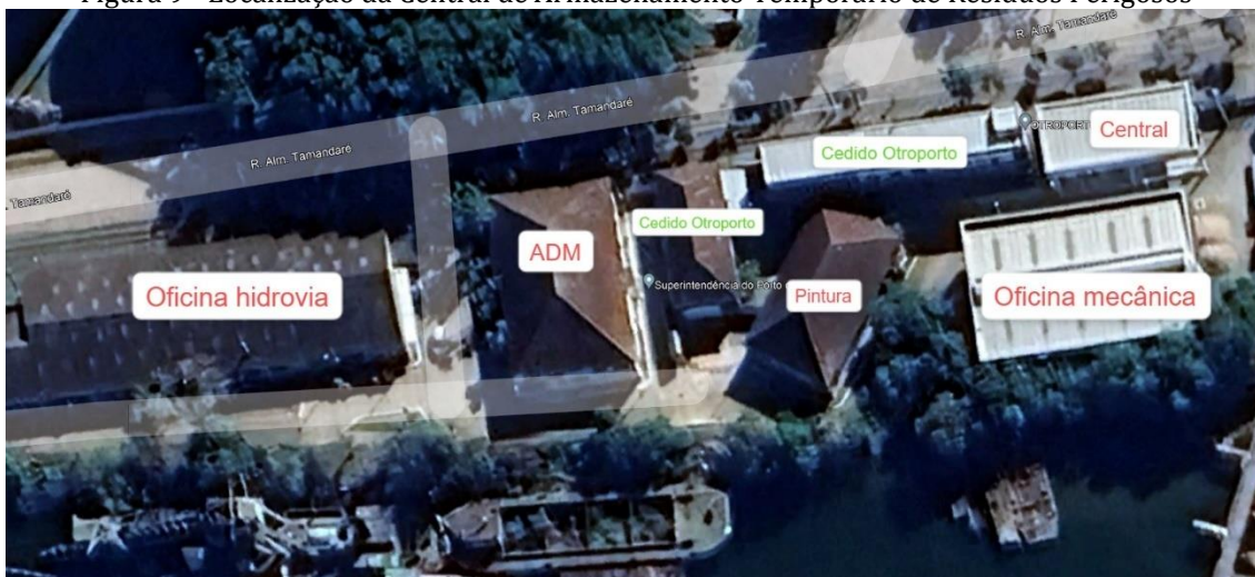
Figura 9 - Localização da Central de Armazenamento Temporário de Resíduos Perigosos
