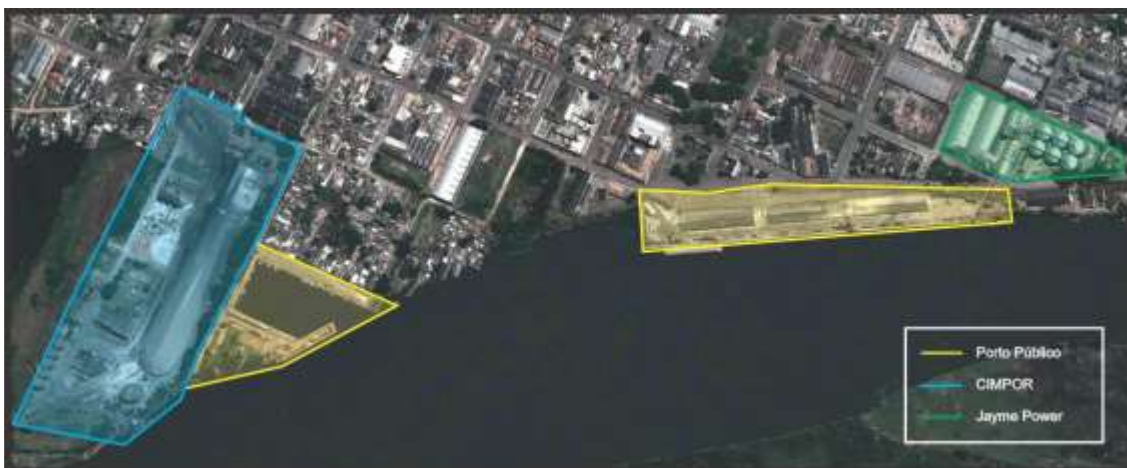
Figura 3 – Estruturas de acostagem e armazenamento. Fonte: SEP, 2013.
