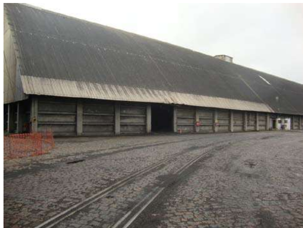
Figura 60 - Vista externa do depósito - CIMBAGÉ Fonte: Autores (2013)
