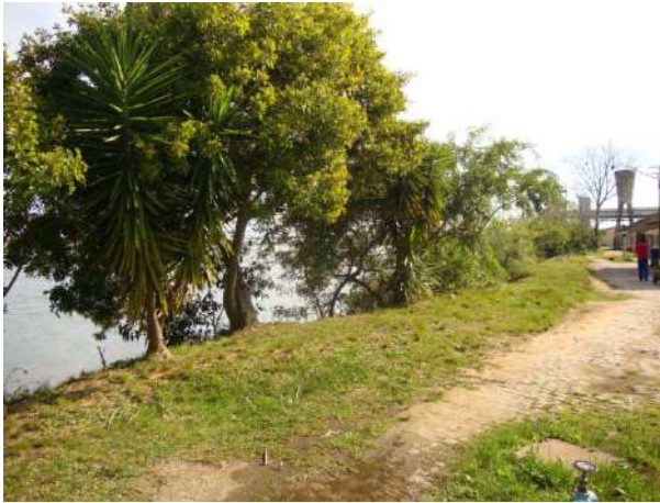
Figura 8: Vista do dique de contenção Fonte: Autores (2013)
