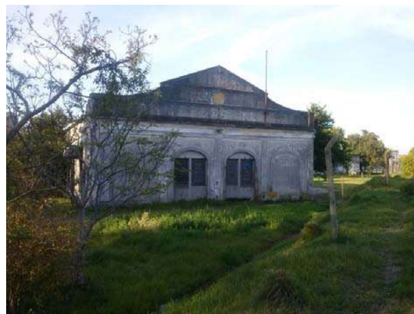
Figura 66 - Vista do prédio desocupado Fonte: Autores (2013)
