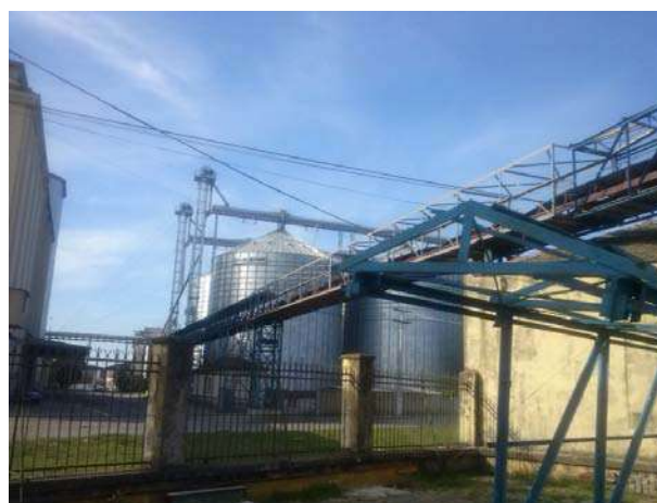
Figura 72 - Vista correia transportadora, a partir da empresa James Power Fonte: Autores (2013)
