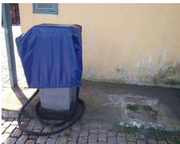
Figura 76 - Bomba de combustível desativada Fonte: Autores (2013)
