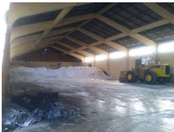
Figura 70 - Vista da carregadeira em operação Fonte: Autores (2013)
