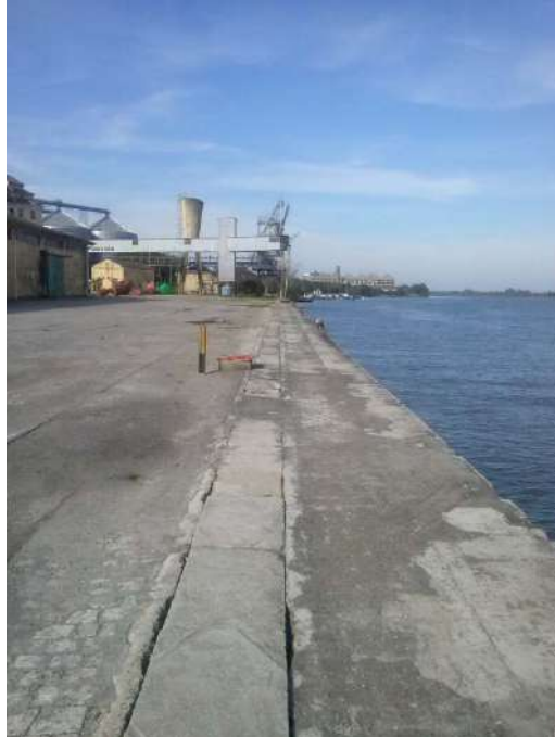
Figura 6: Vista geral da plataforma de atracadouro Fonte: Adaptado do Google Earth
