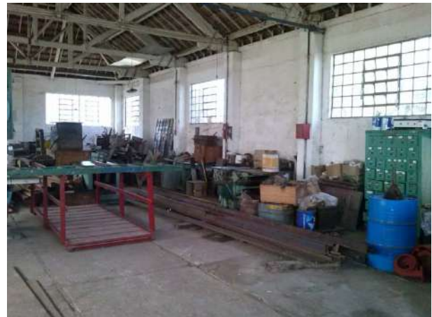
Figura 30 - Vista interna da carpintaria Fonte: Autores (2013)
