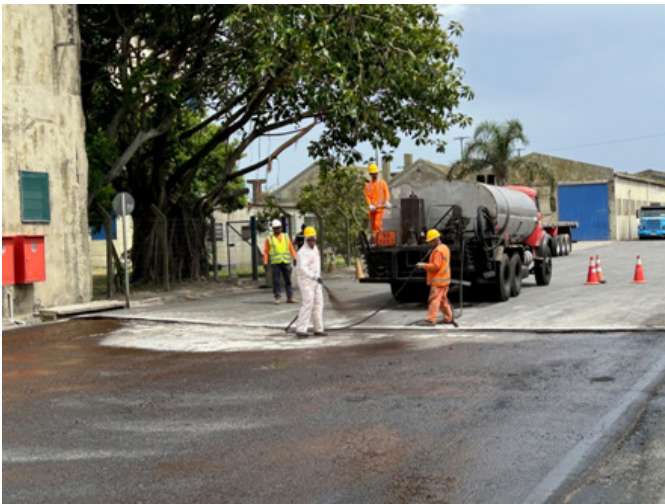
Revitalização das vias internas do Porto Novo
