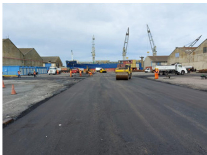
Figura 2: Obra de pavimentação - Unidade Rio Grande
