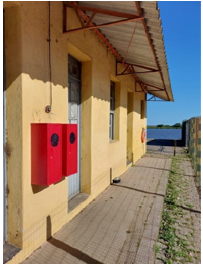
Figura 5: Obra de PPCI - Unidade Pelotas
