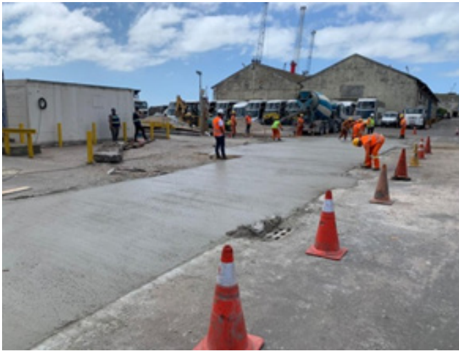
Figura 4: Concretagem de balanças 3 e 4 - Unidade Rio Grande
