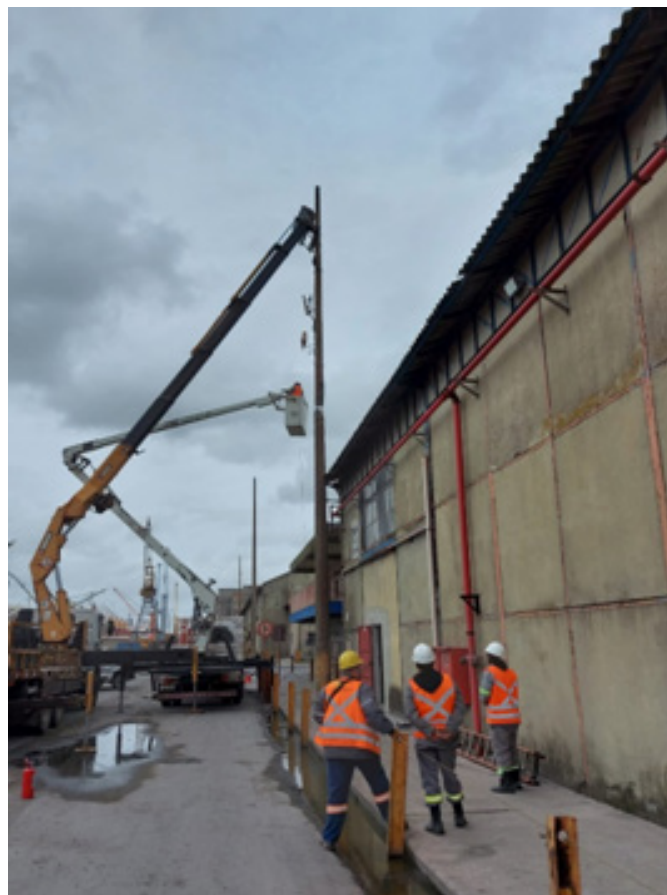
Figura 1: Execução de obra de instalação de postes de iluminação rua B - Unidade Rio Grande
