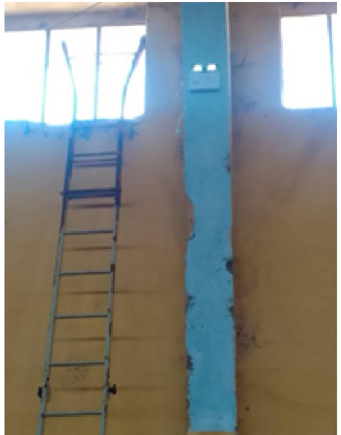
Figura 6: Obra de PPCI - Unidade Pelotas
