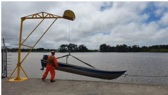
Figura 23: Estrutura instalada para lançamento de embarcações no Porto Novo.
