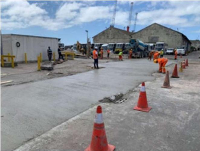
Figura 4: Concretagem de balanças 3 e 4 - Unidade Rio Grande
