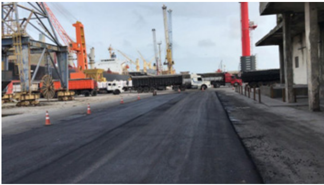
Figura 3: Obra de pavimentação - Unidade Rio Grande
