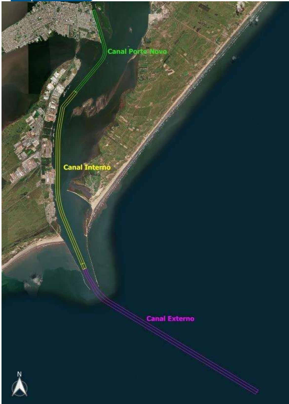
Figura 12 - Canal de acesso do Porto do Rio Grande
