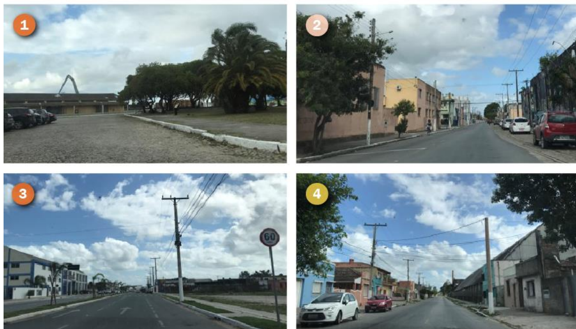
Figura 137 – Condições de infraestrutura das vias pertencentes ao entorno do Porto de Pelotas e do Terminal Logístico Pelotas
