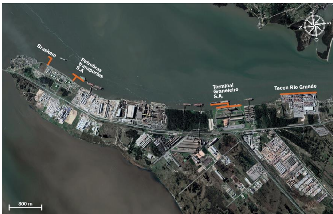
Figura 33 – Acostagem dos terminais arrendados no Superporto no Porto do Rio Grande Fonte: Google Earth (2019). Elaboração: LabTrans/UFSC (2019)
