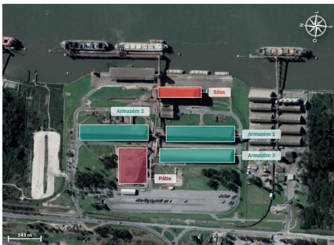
Figura 45 – Estruturas de armazenagem do Tergrasa
