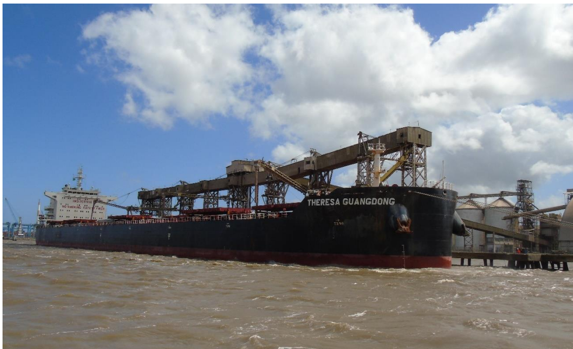
Figura 78 – Navio atracado ao píer do TUP Termasa Fonte: Imagem obtida durante a visita técnica (2018).
