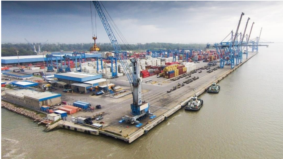
Figura 39 – Cais Tecon Rio Grande Fonte: Imagem fornecida pelo Tecon Rio Grande.
