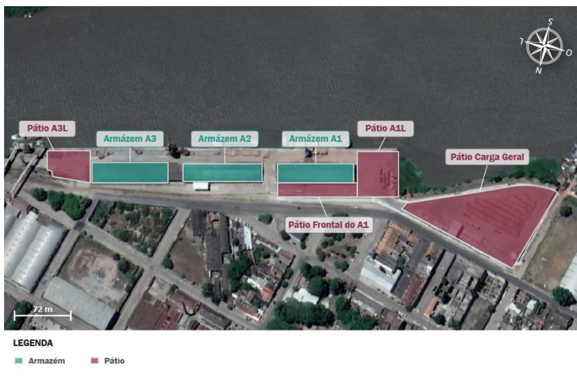
Figura 96 – Infraestrutura de armazenagem do Porto de Pelotas Fonte: Google Earth (2019). Elaboração: LabTrans/UFSC (2019)
