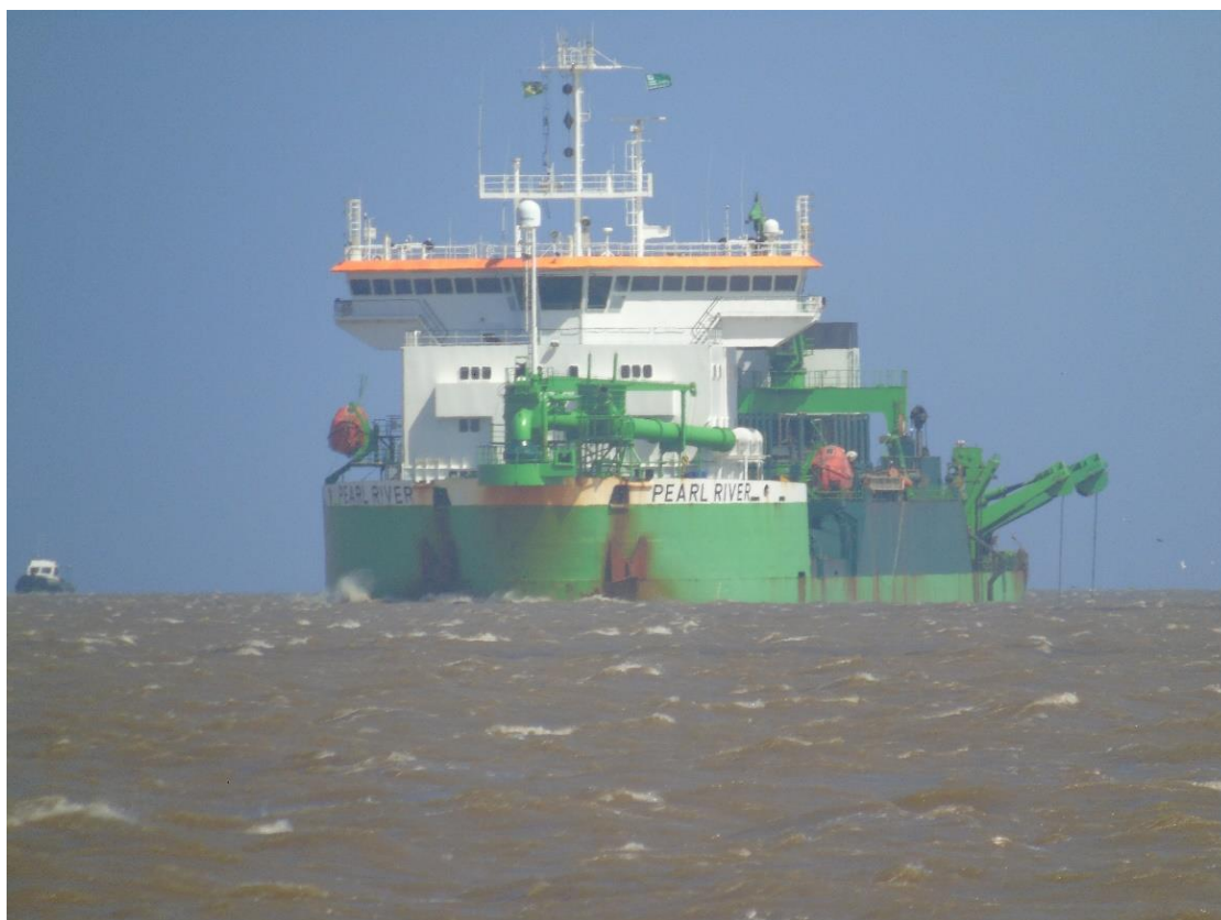
Figura 119 – Draga em operação no Porto do Rio Grande Fonte: Imagem obtida durante visita técnica (2018).
