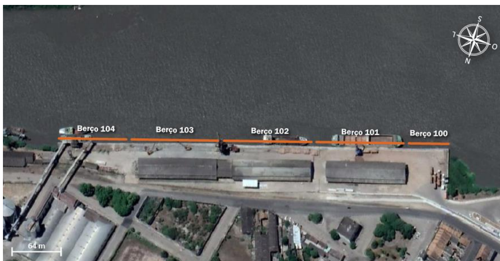
Figura 93 – Infraestrutura de acostagem do Porto de Pelotas Fonte: Google Earth (2019). Elaboração: LabTrans/UFSC (2019)
