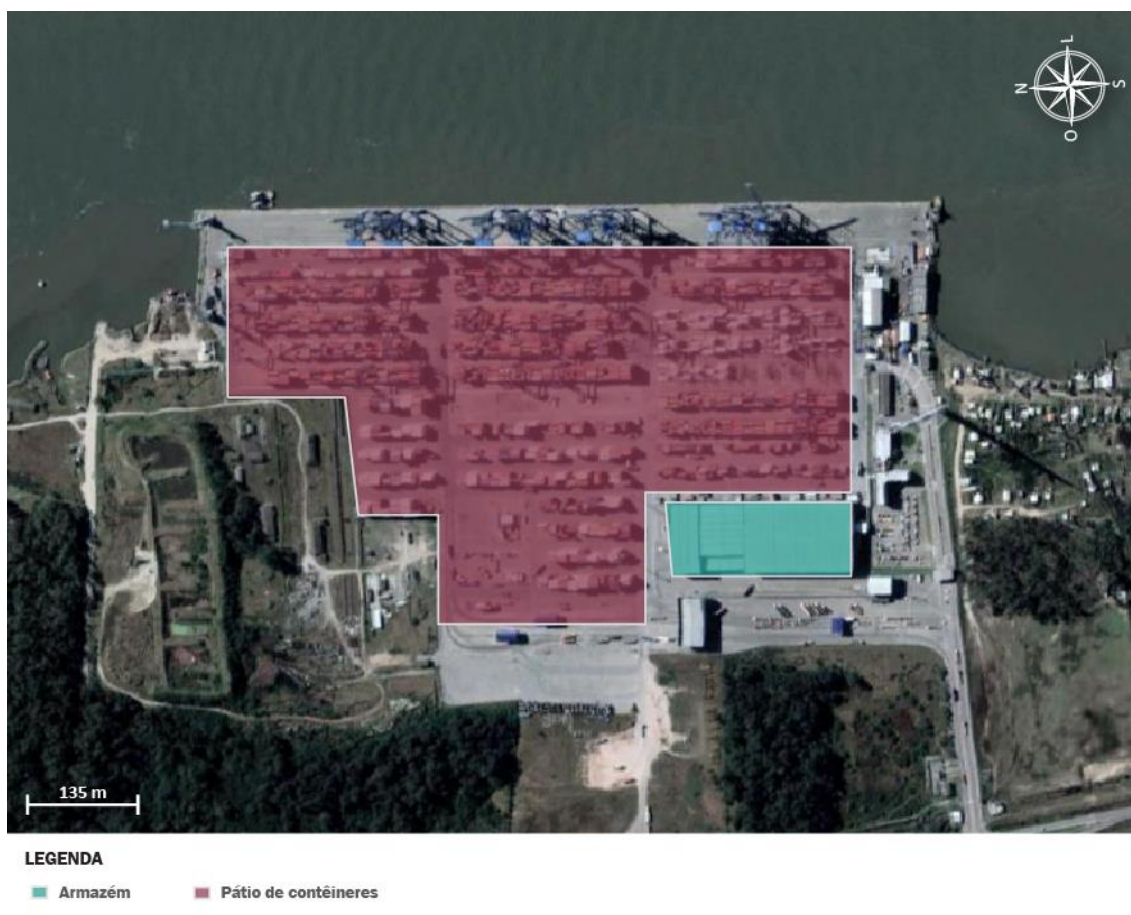
Figura 47 – Pátio de contêineres e armazéns do Tecon Rio Grande
