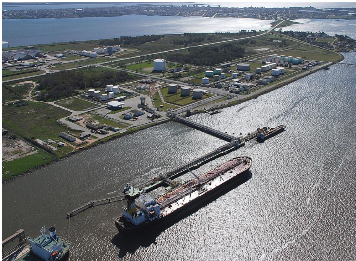
Figura 37 – Píer Transpetro Fonte: Imagem fornecida pela Petrobras Transportes S.A.
