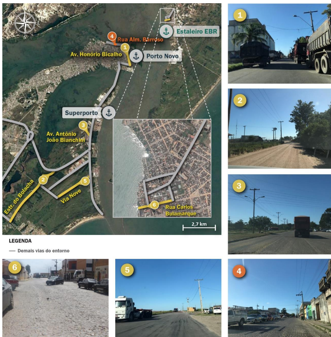
Figura 133 – Condições de infraestrutura das vias do entorno do Porto do Rio Grande e TUPs adjacentes Fonte: Dados e imagens obtidos durante visita técnica (2018), fornecidos pela Autoridade Portuária e pela Prefeitura de São José do Norte (2018) e Google Earth (2018). Elaboração: LabTrans/UFSC (2019)
