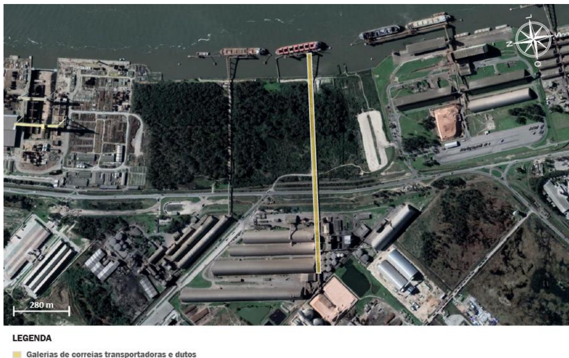
Figura 70 – Galerias de correias transportadoras e dutos do Terbian
