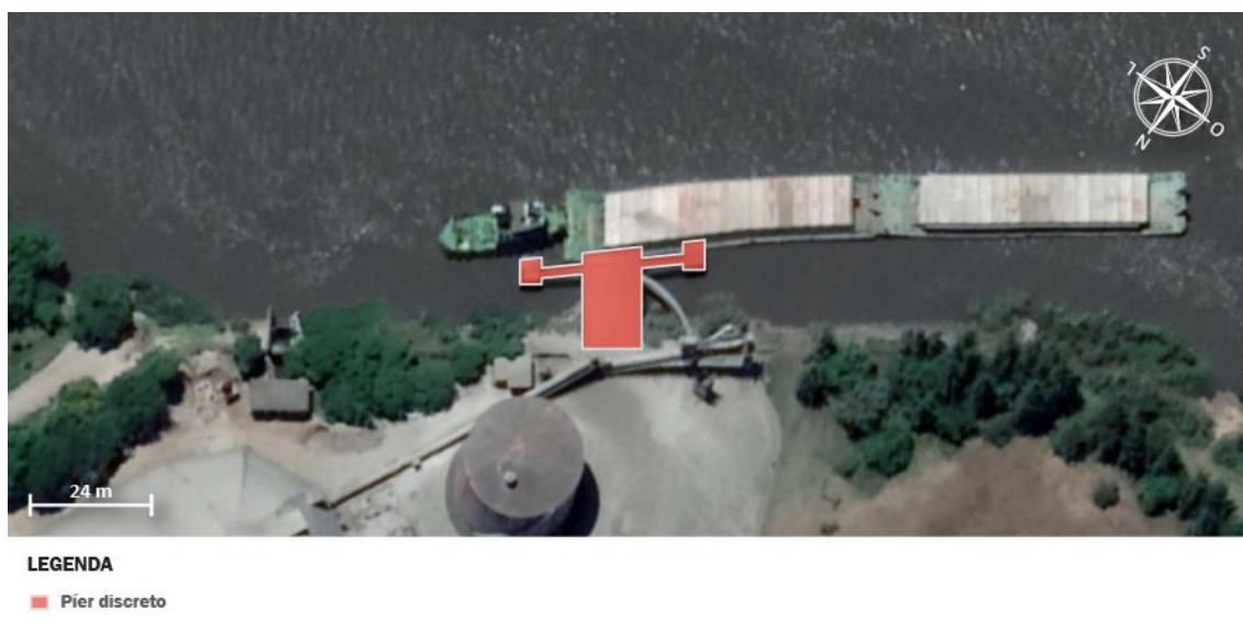
Figura 104 – Infraestrutura de acostagem do Terminal Logístico Pelotas Fonte: Google Earth (2019). Elaboração: LabTrans/UFSC (2019)
