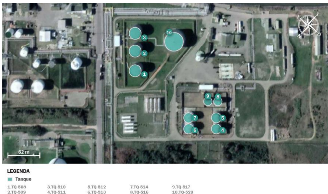
Figura 43 – Tanques de armazenagem da Transpetro
