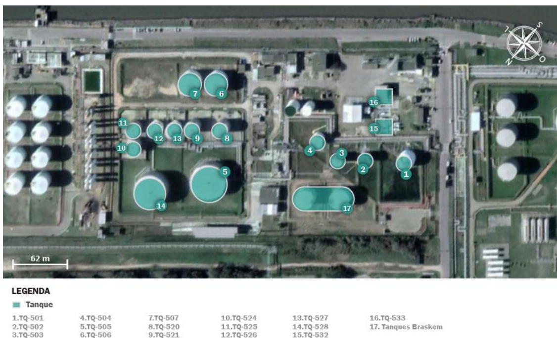
Figura 44 – Tanques de armazenagem da Petrobras.
