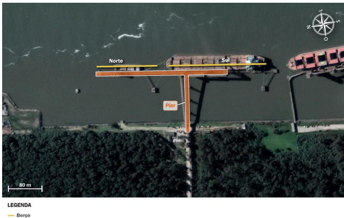
Figura 79 – Infraestrutura de acostagem do TUP Bunge Fonte: Google Earth (2018). Elaboração: LabTrans/UFSC (2019)
