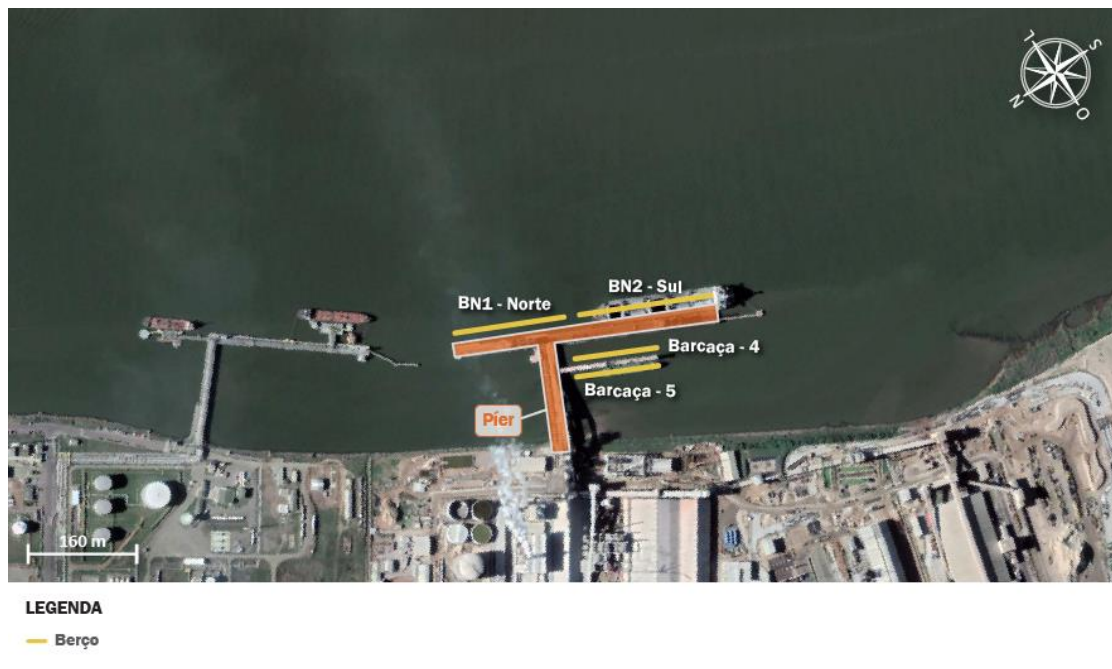
Figura 86 – Infraestrutura de acostagem do TUP Yara Fonte: Google Earth (2018). Elaboração: LabTrans/UFSC (2019)
