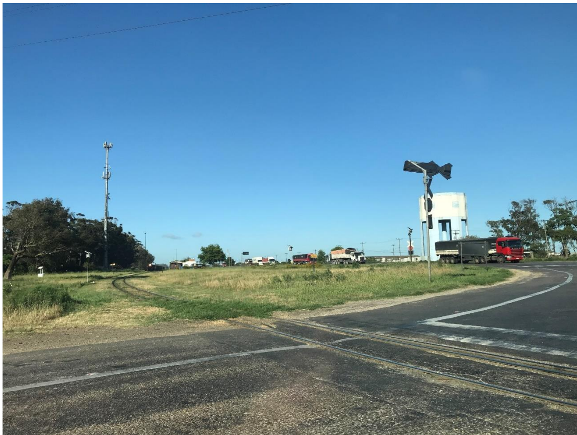
Figura 174 – Passagem de nível no Km 9 no acesso ao Porto do Rio Grande Fonte: Imagem obtida durante a visita técnica (2018). Elaboração: LabTrans/UFSC (2019)
