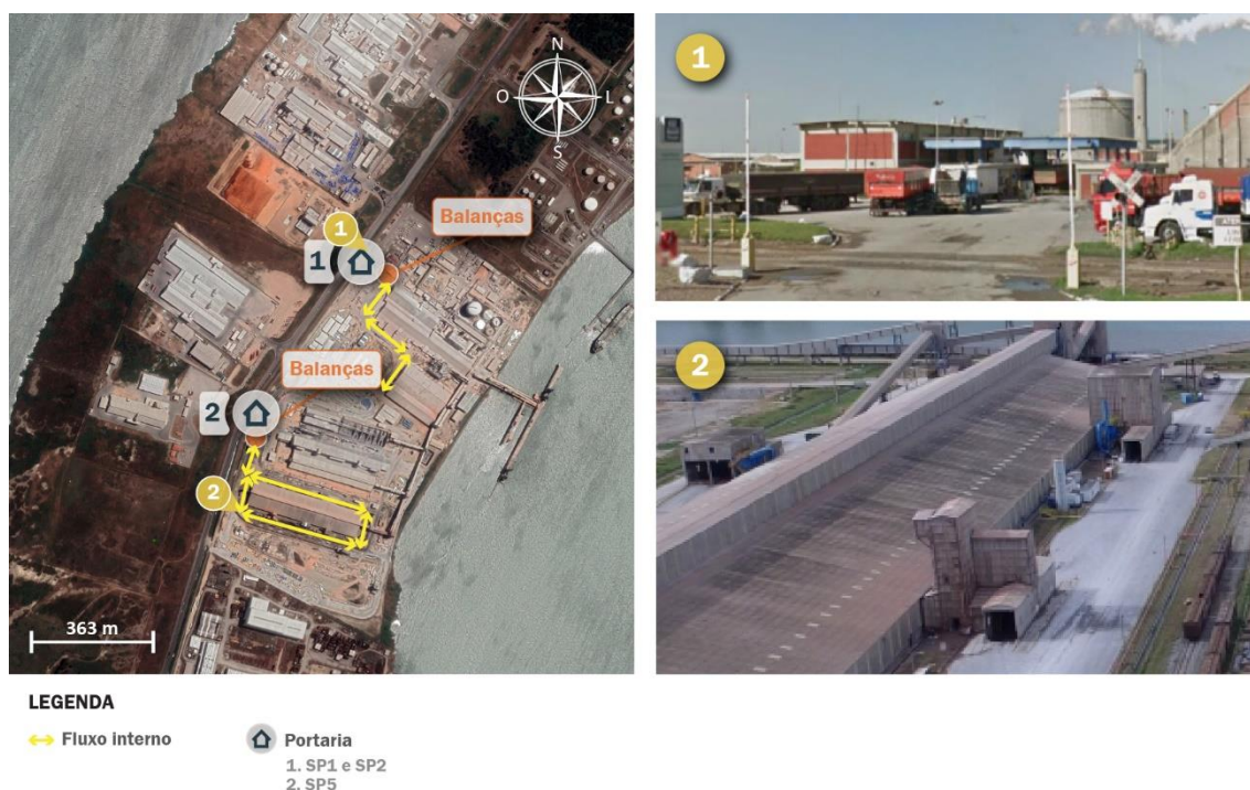
Figura 151 – Fluxo de veículos e condições de infraestrutura das vias intraporto do TUP Yara Fonte: Dados e imagens fornecidos pelo Terminal (2019), Jornal do Comércio (2018) e Google Earth (2018). Elaboração: LabTrans/UFSC (2019)
