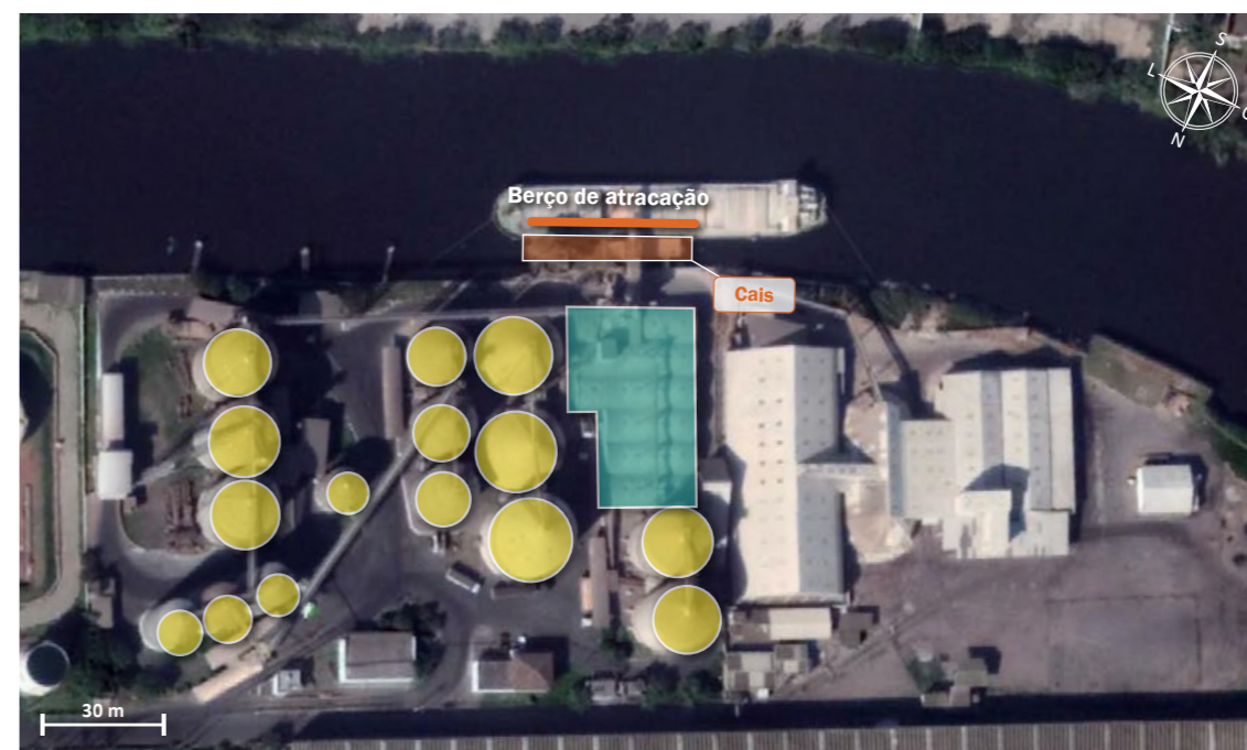
Figura 9 – Infraestrutura de acostagem e armazenagem do TUP Oleoplan Fonte: Google Earth (2019). Elaboração: Ministério da Infraestrutura (2019)
